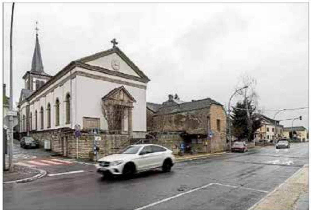
Auf dem mittleren Teil der Rue de Luxembourg wird die Fahrbahn schmaler, Fußgänger bekommen dafür mehr Platz. Foto: Guy Jalay
