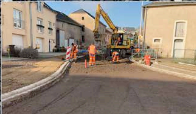
Bordure an Trottoir ginn a verschiddenen Phasen erneiert. Ennerbau an definitive Belag vun der Strooss
