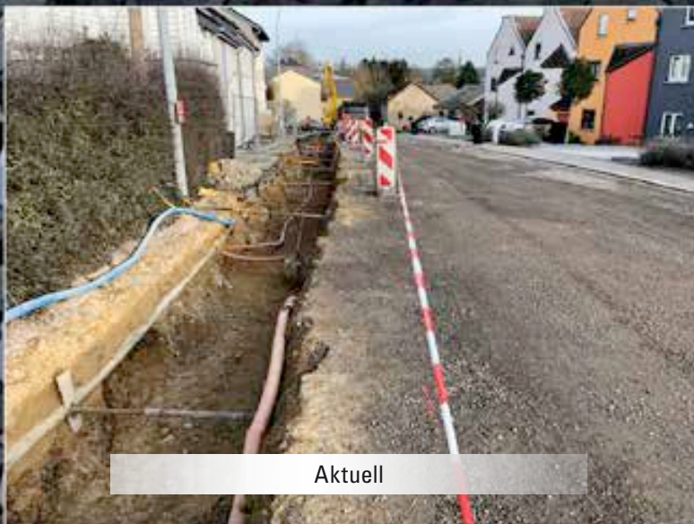
Bordure an Trottoir ginn a verschiddenen Phasen erneiert. Ennerbau an definitive Belag vun der Strooss
