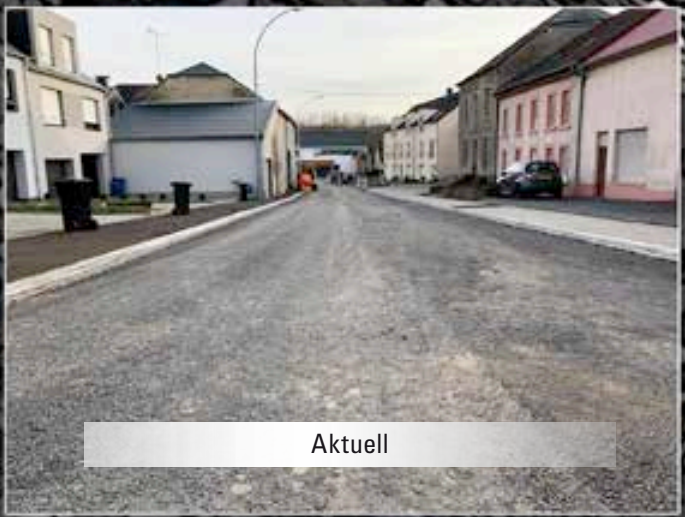
Bordure an Trottoir ginn a verschiddenen Phasen erneiert. Ennerbau an definitive Belag vun der Strooss
