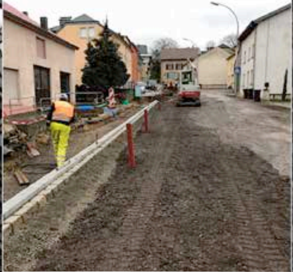
Bordure an Trottoir ginn a verschiddenen Phasen erneiert. Ennerbau an definitive Belag vun der Strooss
